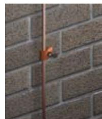
**Зажим фиксирующий стальную полосу к фасаду здания**
